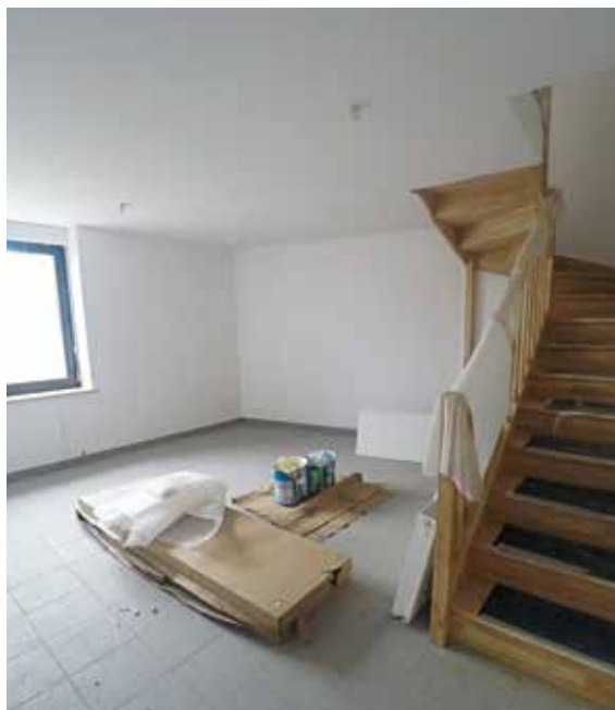
Escalier en bois dans la salle à manger/ salon d'un Duplex T3
