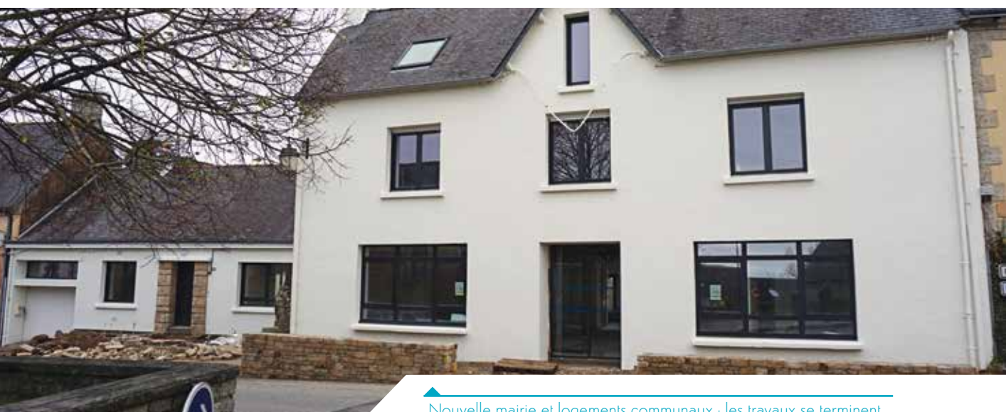
Nouvelle mairie et logements communaux : les travaux se terminent.
