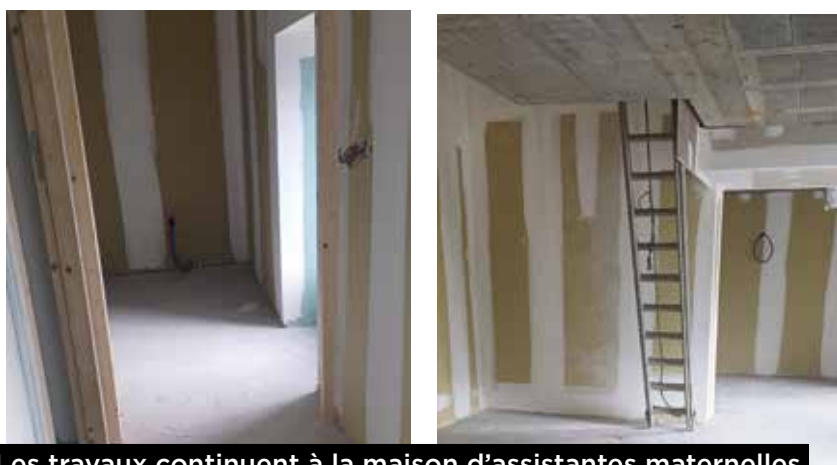
Les travaux continuent à la maison d'assistants maternels
